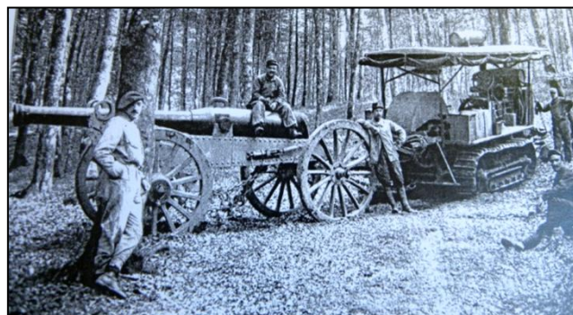
Canon de 155 long hissé au Langenfeldkopf par un tracteur à chenilles (« L'Illustration » n° 3784 du 11 septembre 1915)
